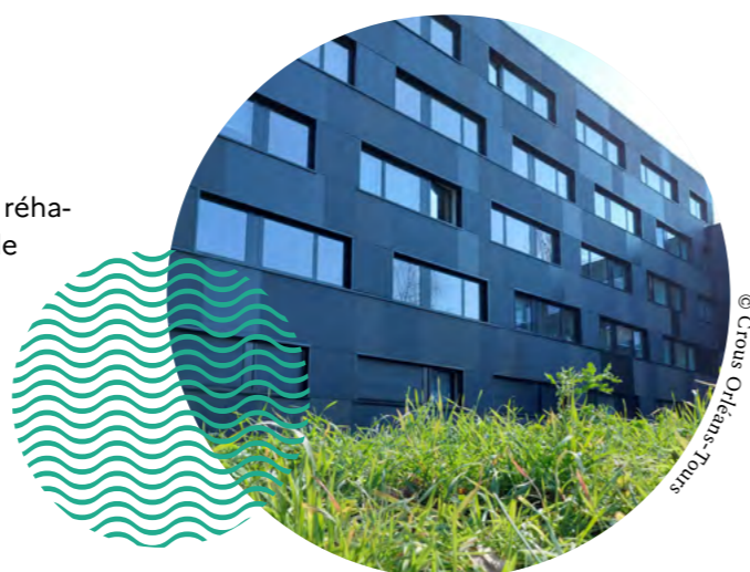
Nouvelles places réhabilitées
